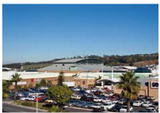
Centro comercial Tyger Valley 48 cámaras MOBOTIX (Sudáfrica)
