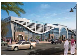
Barwa Commercial Avenue 1.840 cámaras MOBOTIX (Qatar)
